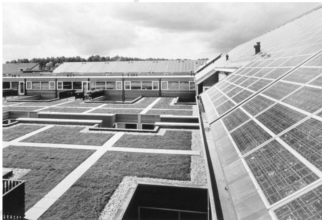
Figura 2.4 Impianto grid connected per l'alimentazione di un'utenza urbana.
