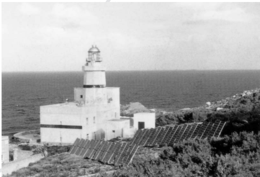
Figura 2.2 Impianto stand alone per l'alimentazione di un utenza isolata (fonte: Anit).
