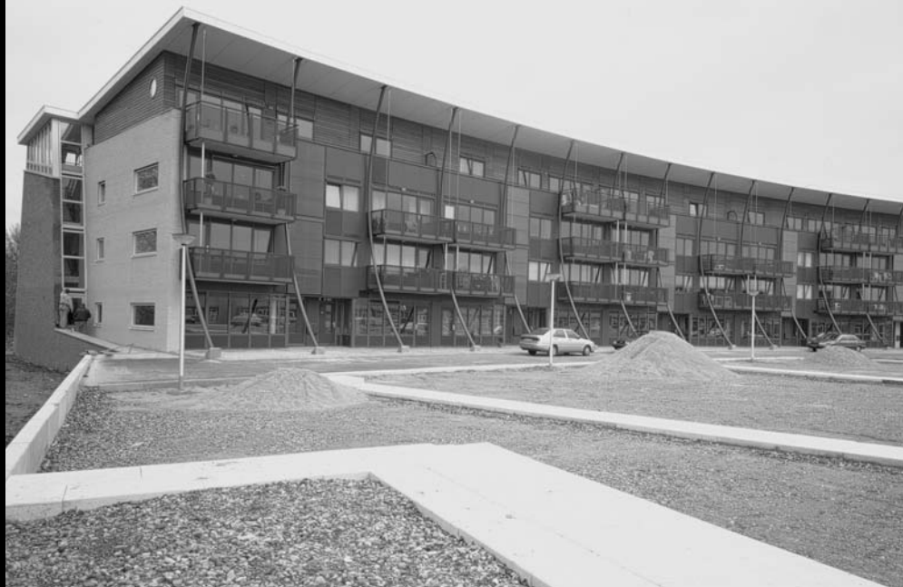
L'edificio Helios a Enschede è costituito da 51 appartamenti e 7 locali per imprese. È un buon esempio di "sostenibilità integrale": progettazione urbanistica sostenibile (collocazione e orientamento), un misto di vita e funzioni e un impianto energeticamente efficiente. Foto: Jan Drewig.
